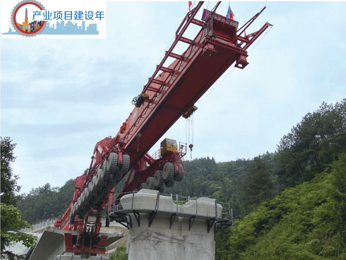
前日，由中铁四局一公司承建的张吉怀铁路三坪大桥首片箱梁平稳架设成功，标志着张吉怀铁路2标一分部管段正式进入架梁施工阶段。 本报通讯员 摄
