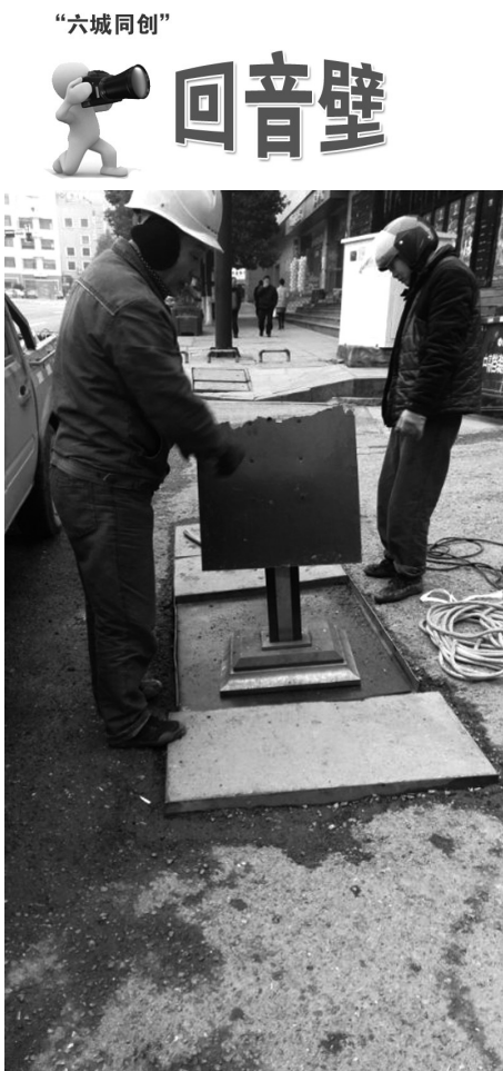
工作人员对紫舞公园对面人行道电力设施进行维修。
