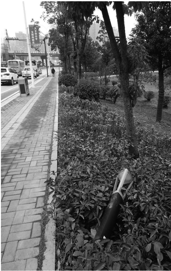
市城区大庸桥公园滨河路多处路灯被破坏。（本栏目图片均由社会监督员提供）
