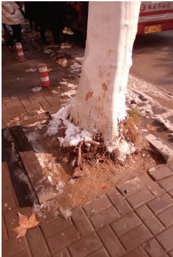
市人民医院门口行道树围档损坏。
