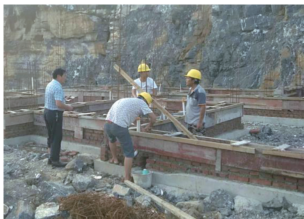
金坪村易地搬迁建设现场
