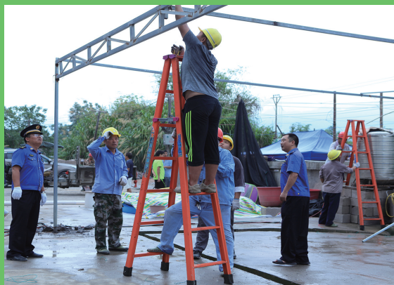
拆除违章棚点
