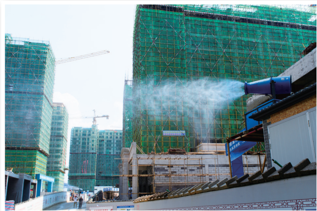
建筑工地喷雾降尘
