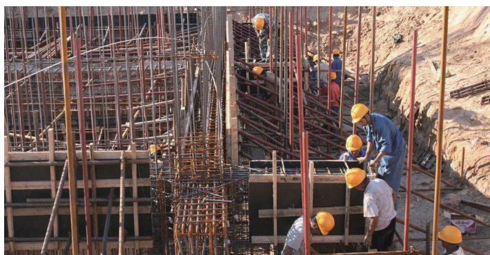
工人们正在施工。
