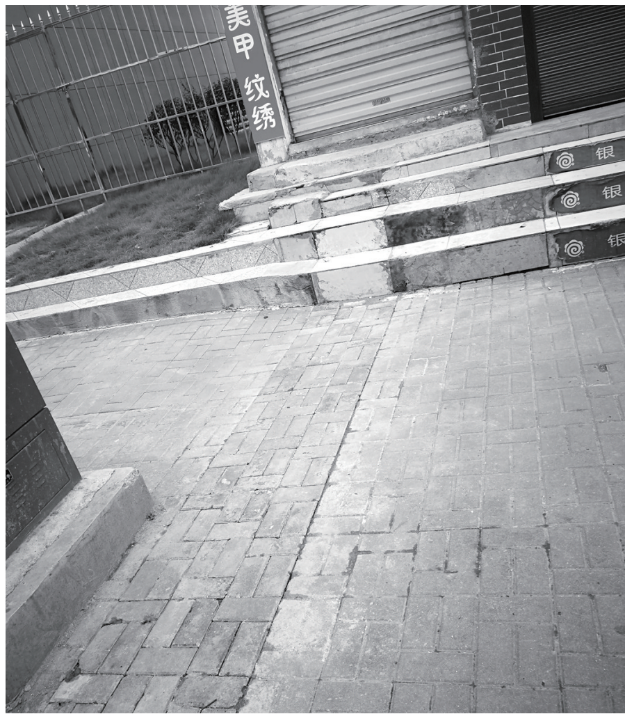
市城区古庸路电子市场对面人行道边一处污水流向街道问题解决了。
